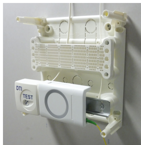
> PTO-T2 installée sur rail DIN
