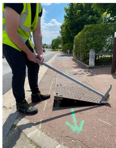
Utilisez le crochet et la pointe du marteau à plaque afin de soulever la plaque.
